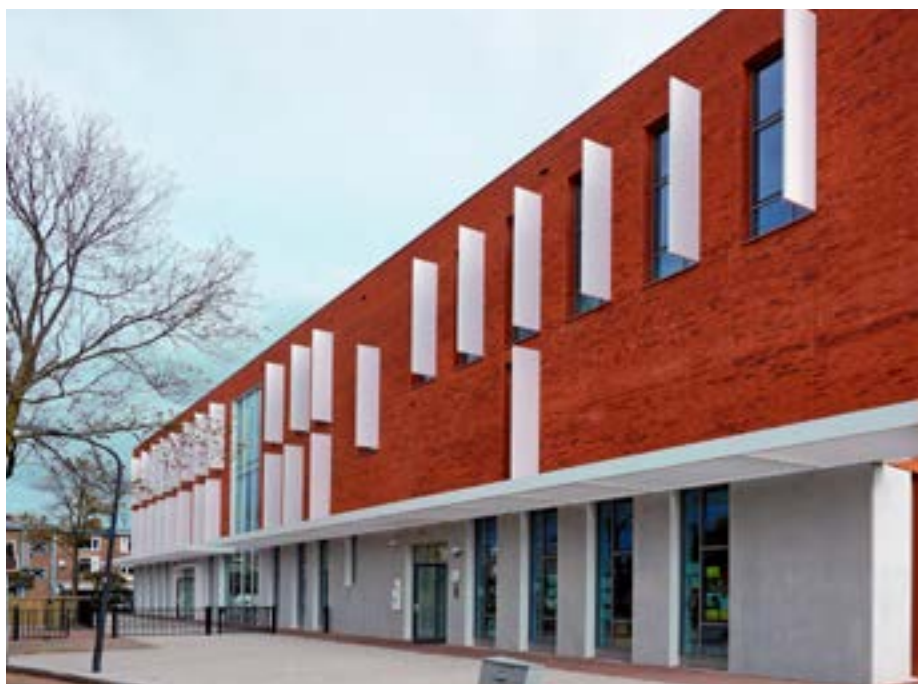
Zonwering in de vorm van verticale panelen
