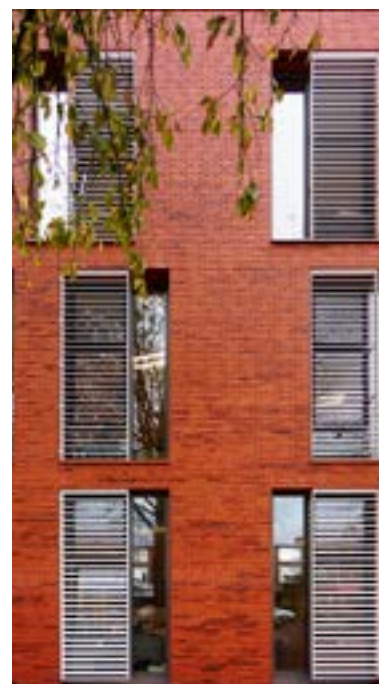
Zonwering in de vorm van vaste buiten lamellen
